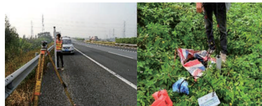
图 21 路面沉降和路基水平位移现场观测
