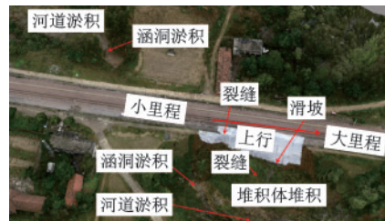
图4 铁路水害沿线某路堤坡脚积水航拍图
