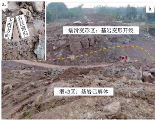
a. 蠕滑变形区与滑动区界线; b. 蠕滑变形区滑向偏离岩层倾向
