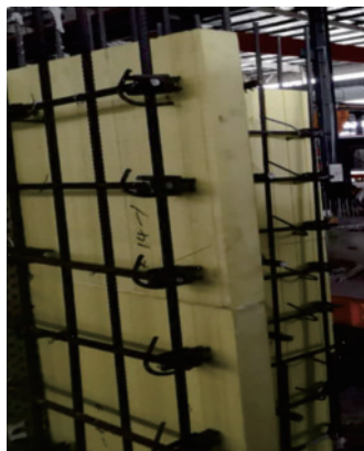
图3 保温板及配筋
