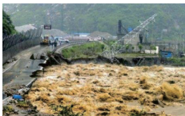
图1 泥石流冲击作用下杆塔发生倾斜
