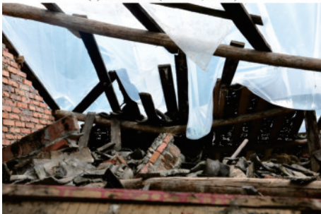
(b) 屋面破坏(燕子沟镇, IX度)
