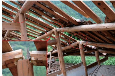
(b) 屋架拔榫(挖角村,Ⅶ度)
