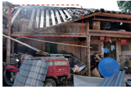
(a) 屋面破坏(燕子沟镇,Ⅷ度)
