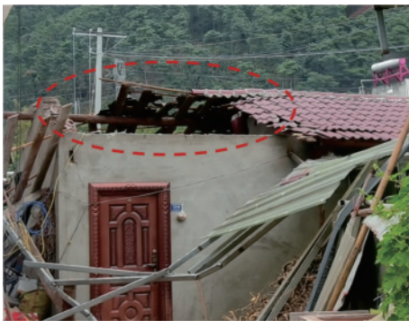
(a) 屋面破坏(得妥镇, IX度)
