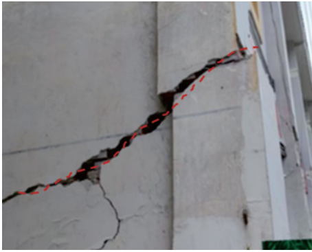
图10 砖柱单段剪切破坏(得妥镇, IX度)
