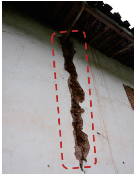
(a) 墙体连接破坏(宜东镇, VII度)
