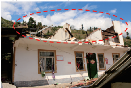
(c) 局部倒塌(得妥镇, IX度)
