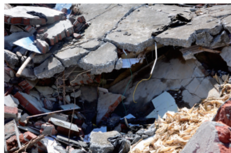
图4 整体倒塌(新民乡,Ⅶ度)
