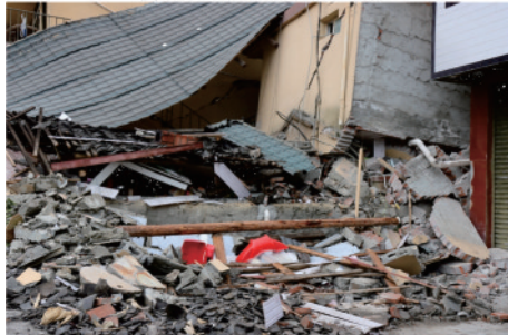
(d) 局部倒塌(磨西镇, IX度)
