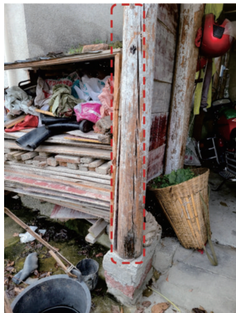
图12 木柱倾斜(冷碛镇, VII度)
