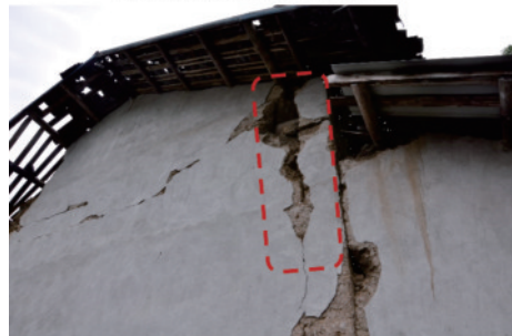
(b) 墙体受剪破坏(新民乡, VII度)
