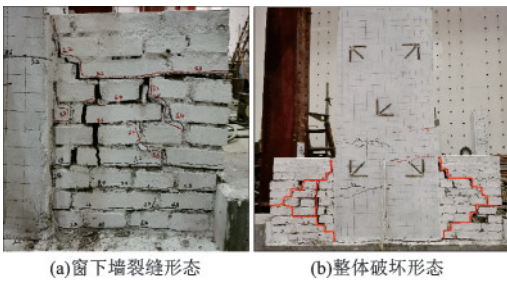
图7 高宽比1.4砌体墙W-4墙体破坏状态
