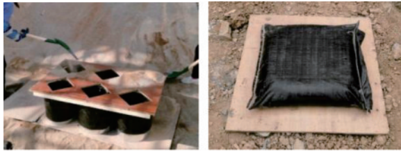
(a) 土工袋装袋 (b) 土工袋单体
