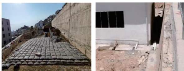
(a) 土工袋垫层 (b) 房屋主体完工
