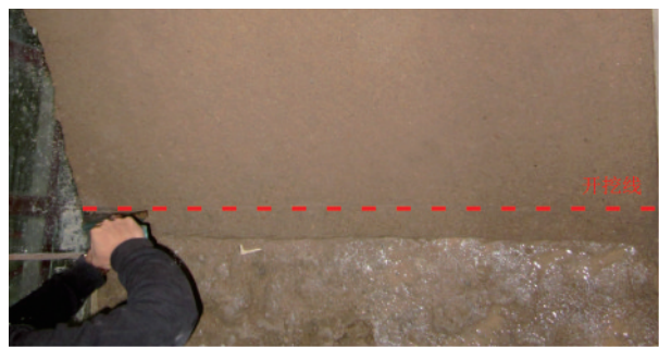
(a) 削坡过程
