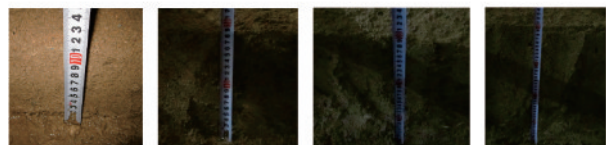
(b) 开挖至10 cm (c) 开挖至20 cm (d) 开挖至30 cm (e) 开挖至40 cm
