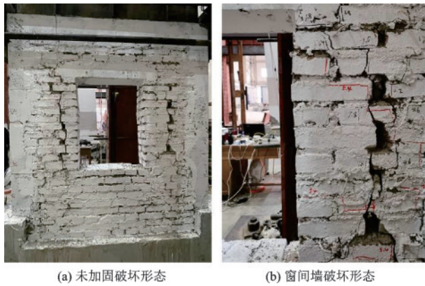
图 5 试件 URMW-1 破坏时的裂缝开展和破坏形态
