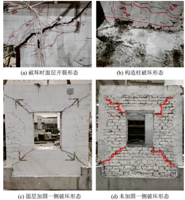
图 6 试件 SRMW-2 破坏时的裂缝开展和破坏形态
