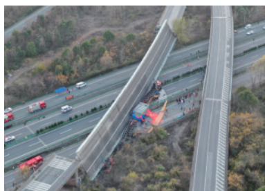
图1 独柱墩弯桥倾覆事故
