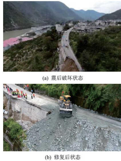
图7 省道S211线金光大桥段修复
