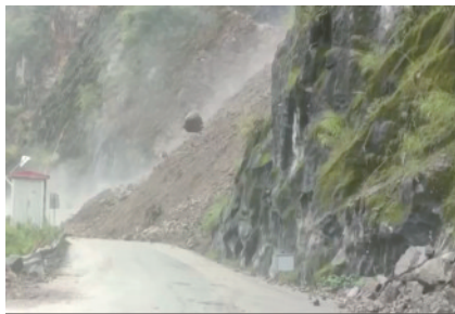
(a) 两草路边坡崩塌滚石
