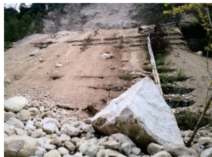
(a) 磨西河大桥处崩塌落石掩埋路基
