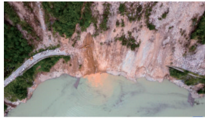
(a) 石棉县草科乡段破坏情况
