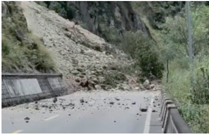
图4 G318道路甘谷地超限站处崩塌
