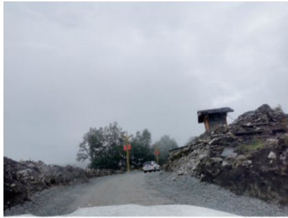
(b) 修复后的便道
