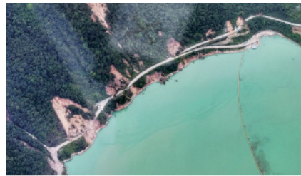
(b) 石棉县至王岗坪乡段破坏情况
