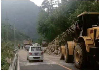
图5 G108道路石棉县境内宰羊段崩塌
