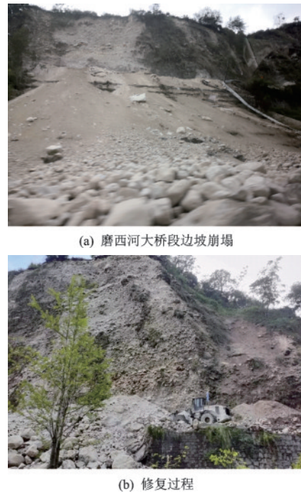
图8 省道S434磨西河大桥段修复
