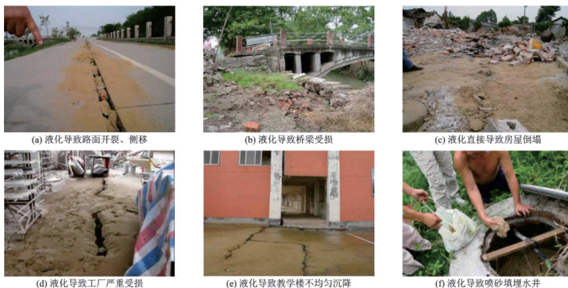
图7 M_s 8.0级汶川地震典型液化震害 [23]
