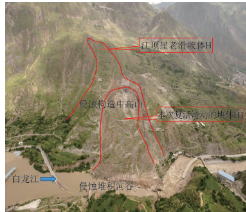
图3 江顶崖滑坡地形地貌
