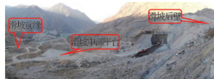
图7 江顶崖滑坡体现场
