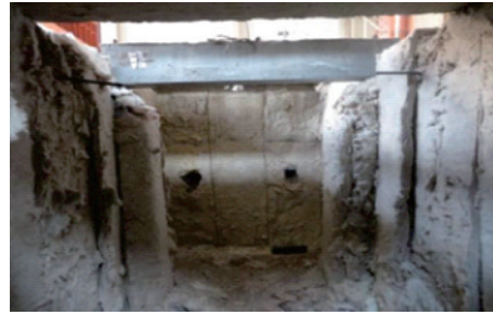
图5 炉内简支梁放置
