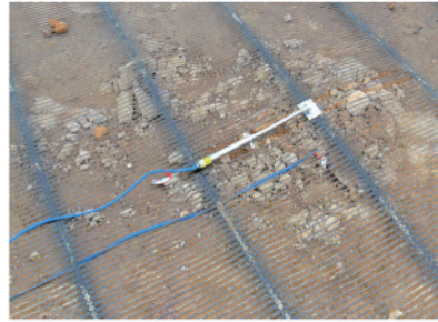
图3 安装测试元器件 Fig.3 Installation of instruments
