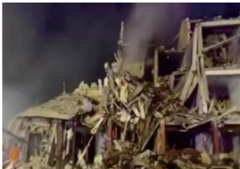
图4 核心区域内居民楼倒塌情况
