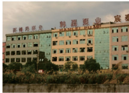
图7 周边办公楼损坏(650 m)
