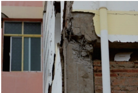
图 6 填充墙的存在造成柱端剪压破坏
