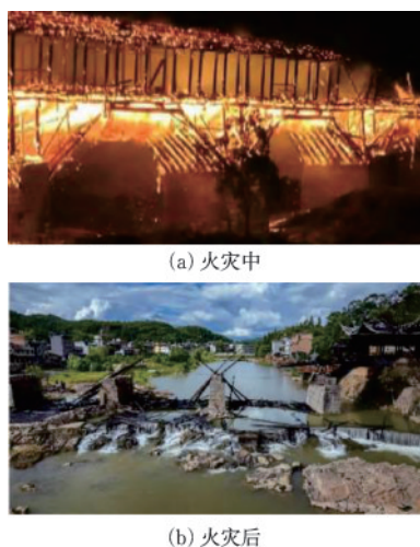
图2 万安桥火灾损毁场景 [29]
