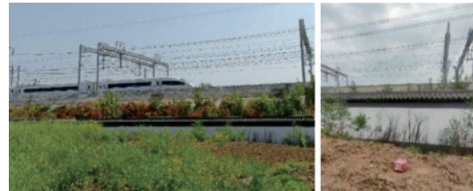
图3 商合杭高铁测试现场
