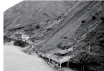
(b) 窄板沟公路明洞, 15~20 m/s 冲击速度
