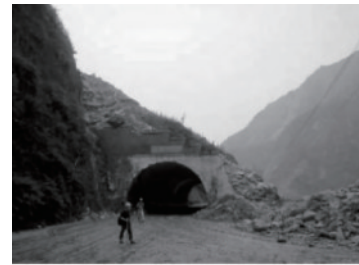
(a) 麻柳湾公路明洞, 7.8 m/s 冲击速度
