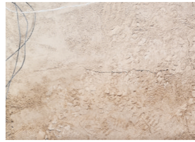
图6 加载0.1g X向坡顶裂缝发育
