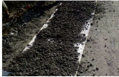
图4 GCL摊铺二灰碎石土
